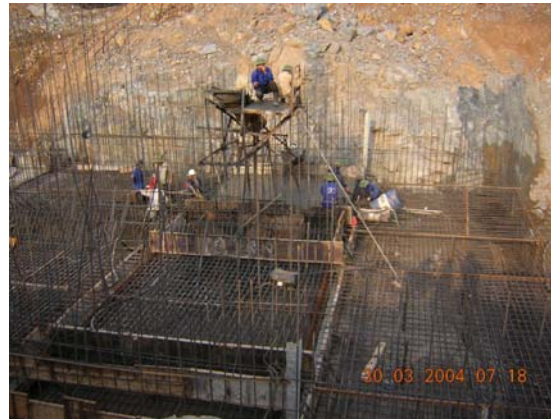
Thi công cầu lắp đặt cốt thép, cốp pha tại thủy điện Sê San 4
