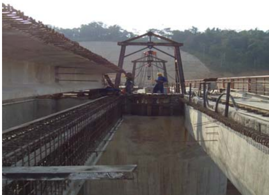
Thi công cầu giao thông thủy điện Sê San 3A
