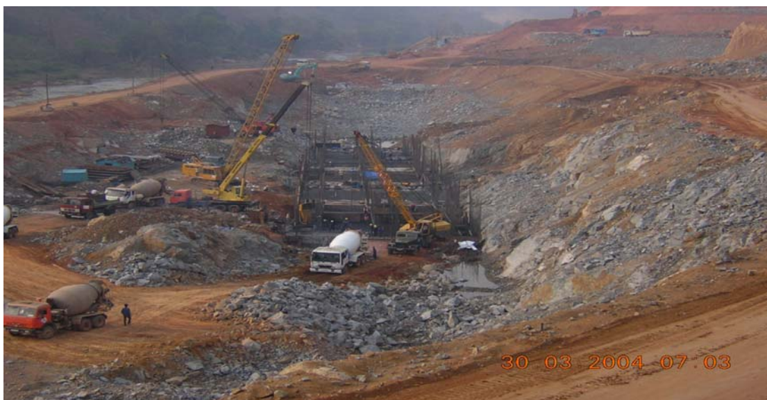
Thi công hố móng đập tràn
